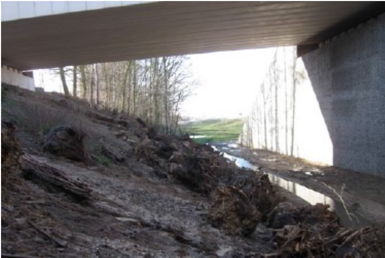
Figuur 18: Voorbeeld stobbenrij onder brug.
