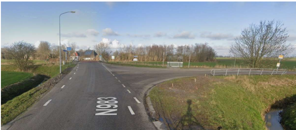
Foto kruising N983 en Van Swinderenweg met zicht oop de brug
