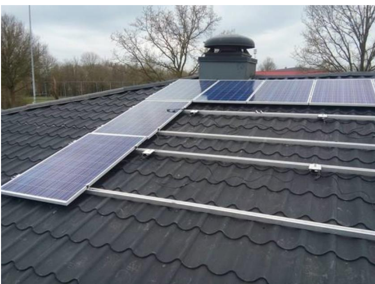
Figuur 1. Horizontale bevestigingslatten onder zonnepanelen
