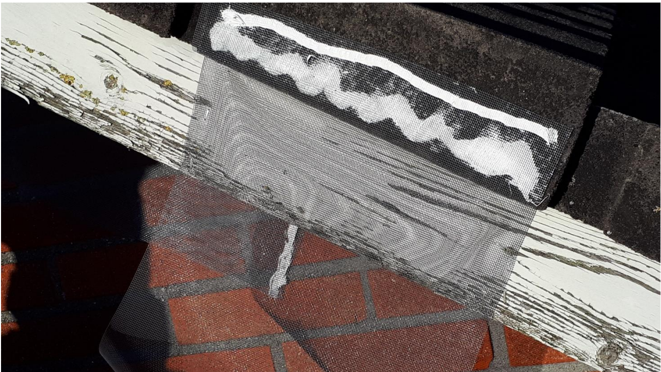
Figuur 4. Goed voorbeeld van exclusion flaps van fijnmazig gaas. De zijkanten zijn hier met nielen en lijm vastgezet.
