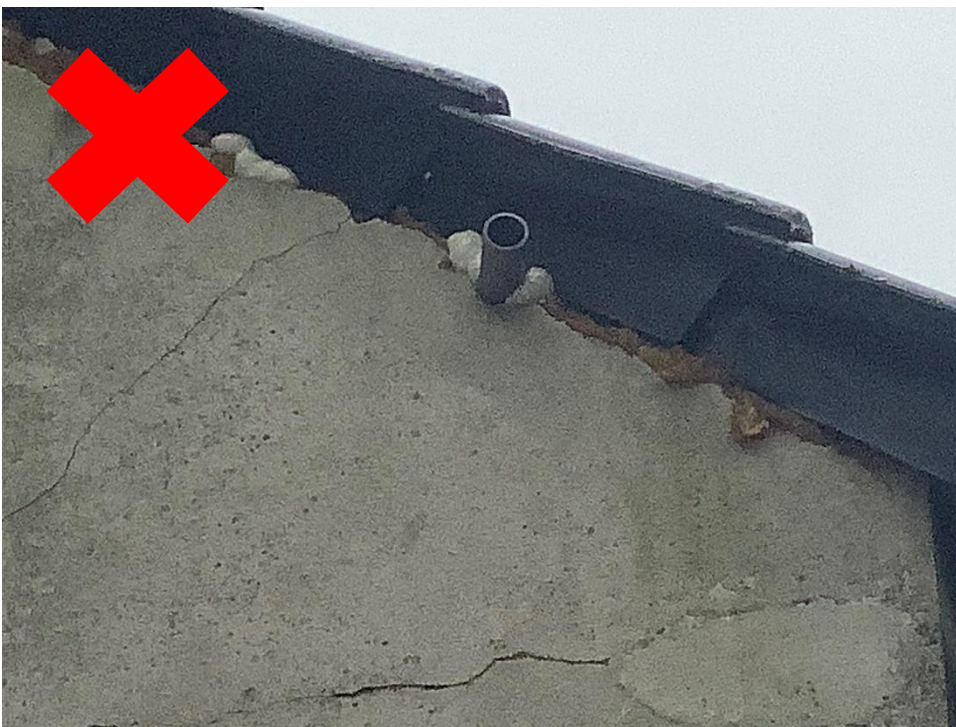
Figuur 6. Foutieve 'exclusion flap' (het pijpje).
