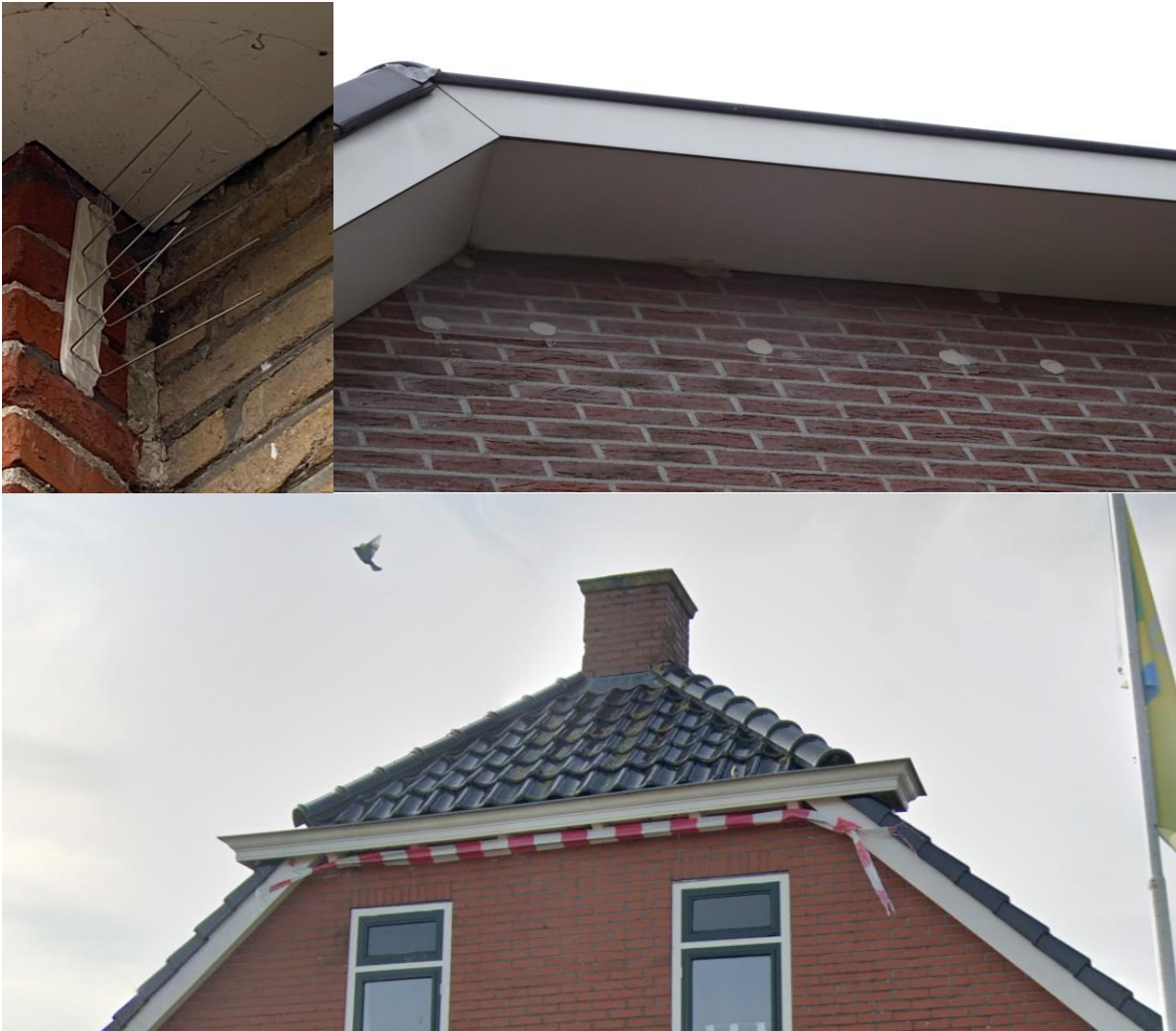
Figuur 14. Methodes om huiszwaluw te ontmoedigen, namelijk duivenpinnen (linksboven), gladde plaat of zeil (rechtsboven) en met een lint (onderin).
