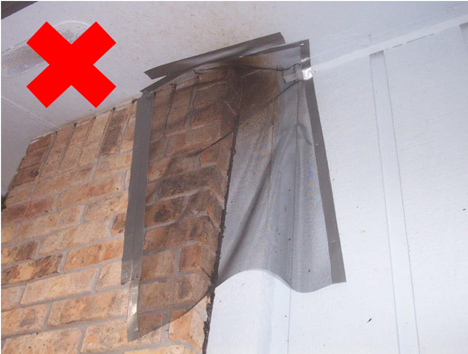
Figuur 5. Foutieve toepassing van exclusion flaps.
