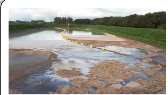
Grondbassin in gebruik
