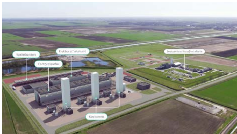
Figuur 4.13: De luchtscheidings- en menginstallaties bij Zuidbroek ten behoeve van stikstofbuffer bij Heiligerlee. Bron: Gasunie.
