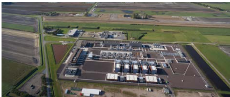
Figuur 4.12: De gasopslaglocatie nabij Zuidwending. Hier wordt in 5 cavernes aardgas gebufferd.
