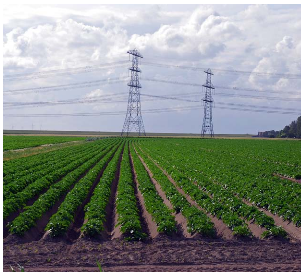
Hoogspanningsmasten bij Eemshaven
