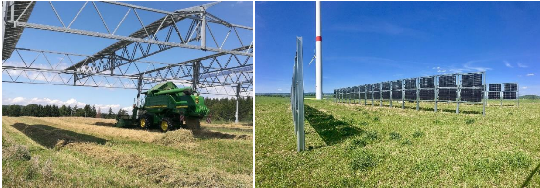
Figuur 6. Voorbeeld van een zonnepark hoog boven de grond waardoor landbouw onder de stellages mogelijk blijft (links). Voorbeeld van bifaciale panelen (rechts) die eveneens landbouw tussen rijen panelen mogelijk maakt (bron: https://de.wikipedia.org/wiki/Photovoltaik-Freifl%C3%A4chenanlage#Agrophotovoltaik, Agrovoltaik ).
