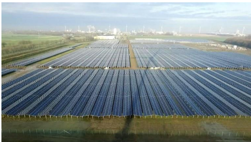
Figuur 5. Voorbeeld van een zonnepark met een oost-west opstelling van panelen. Delfzijl, Groningen.
