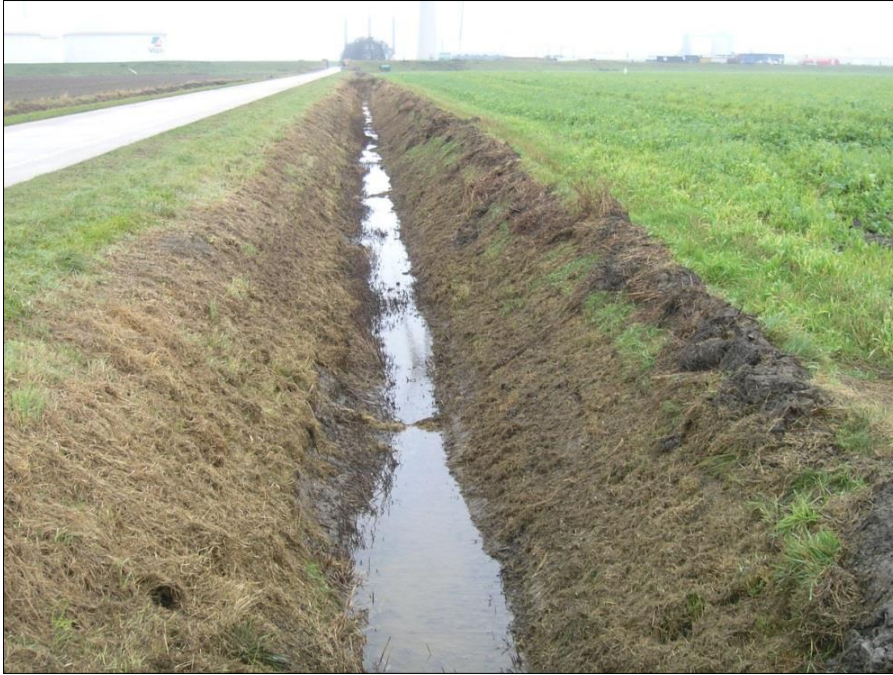
Foto 4. Geschoonde bermsloot langs de Klaas Wiersumsweg.
